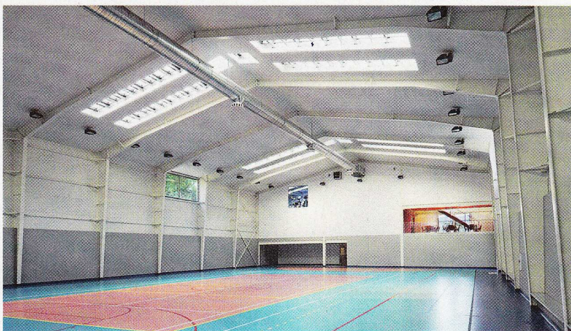
Konstrukci haly tvoří ocelové rámy v pětimetrových rozstupech, obvodové stěny jsou z panelů Kingspan.
