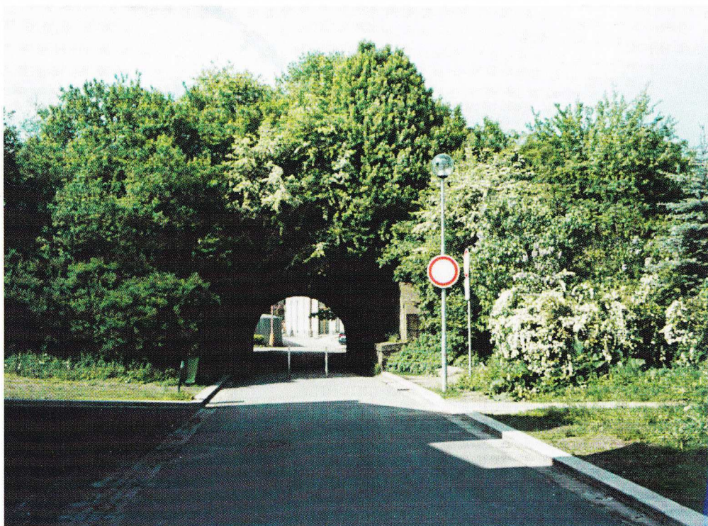
Náchod, tunel pod železničním náspem, stav z roku 2001
